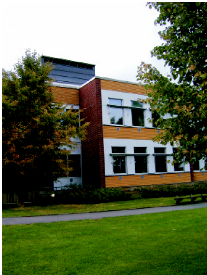
Fig.12 Hybridventilation i Tångaskolan, Falkenberg. På taket syns en skorsten (solskorsten) och under varje fönster skymtar öppningar för tilluften.
